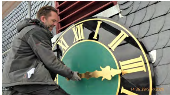
Bild oben: Der verschieferte Kirchturm. Darunter: Herr Schneider fixiert die vergoldeten Zeiger. Bild links unten: unsere Baubegleiter Klaus Schultze, Ludwig Held, Michael Schmidt auf dem Kirchturm Mitte Juli. Fotos: G. Buchwald
